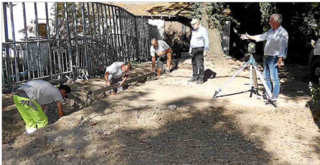
▣ Les services techniques municipaux travaillent sur les fondations du futur parc.
