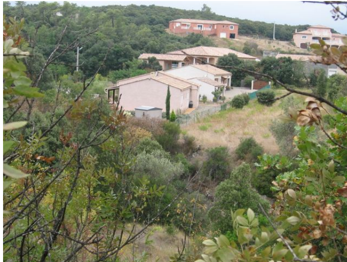
Habitations récentes en lit majeur en amont de Laurens
