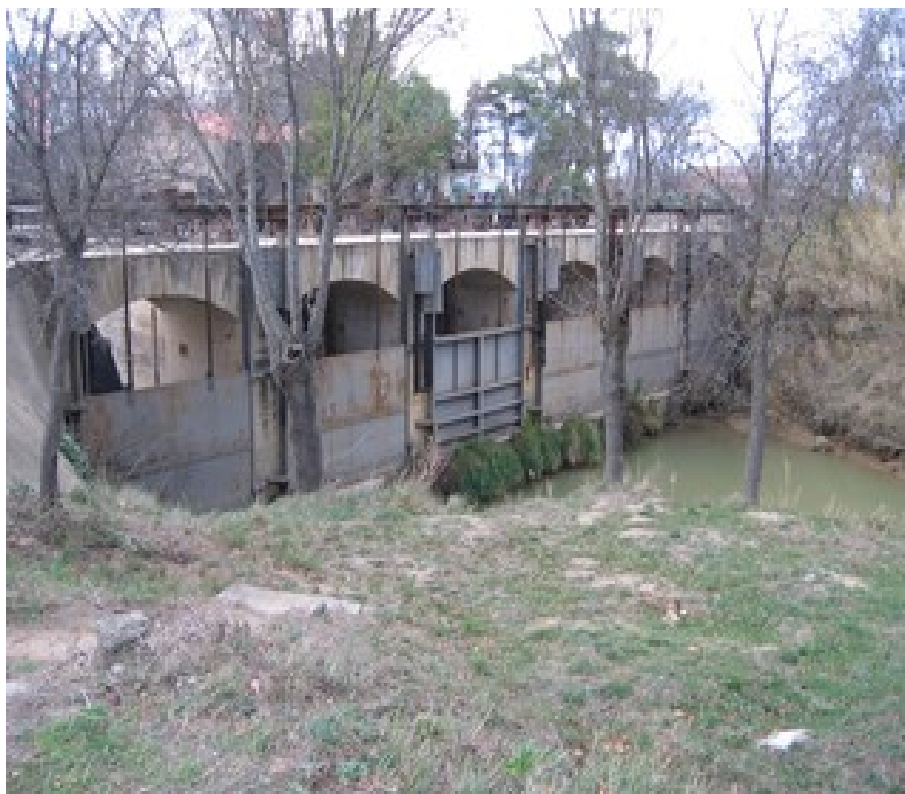
Ouvrage pour la traversée du Canal du Midi
