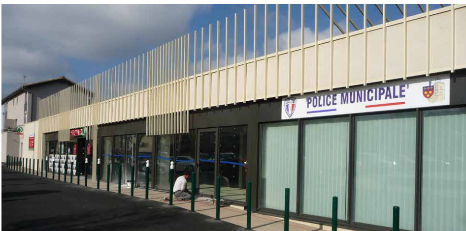
Travaux d'aménagement et d'accessibilité de l'allée Charles de Gaulle par les Services Techniques
