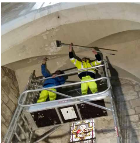
Réfection d'une coupole à l'église
