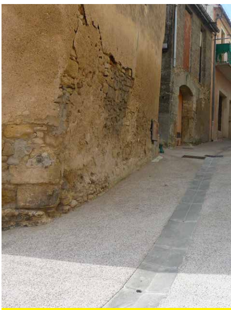
Réfection de la voirie rue du Château
