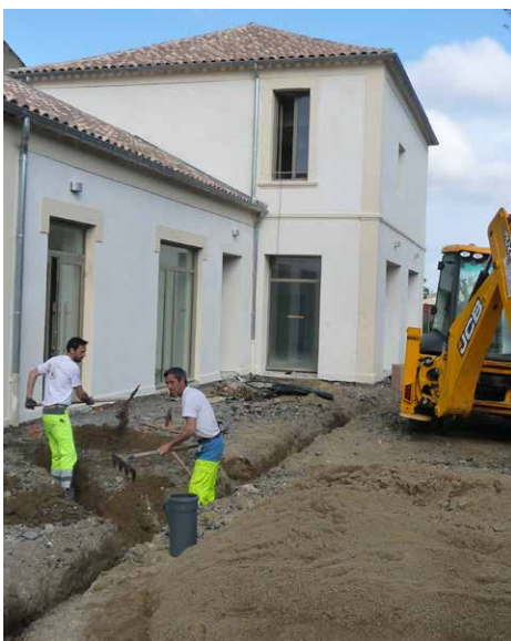
Les travaux d'aménagement intérieur et extérieur de l'Espace Intergénérationnel
