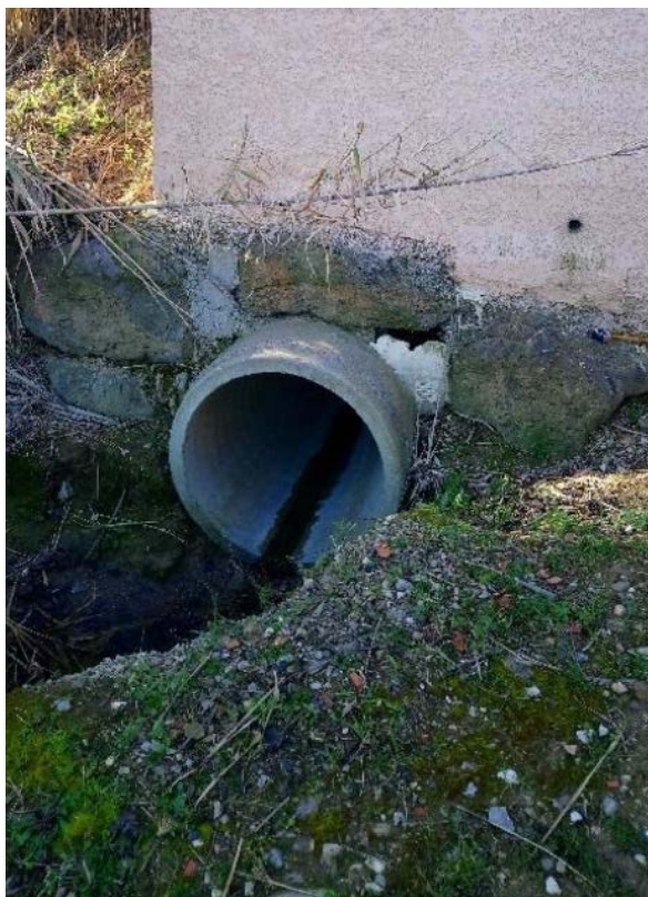
Figure 15 : Buse diamètre 1000 mm impasse de la Condamine
