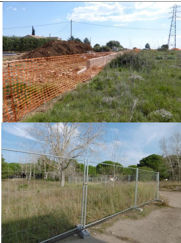
Figure 3 : exemple de balisage avec clôture de chantier souple ou dure – CBE, 2018 et 2017
