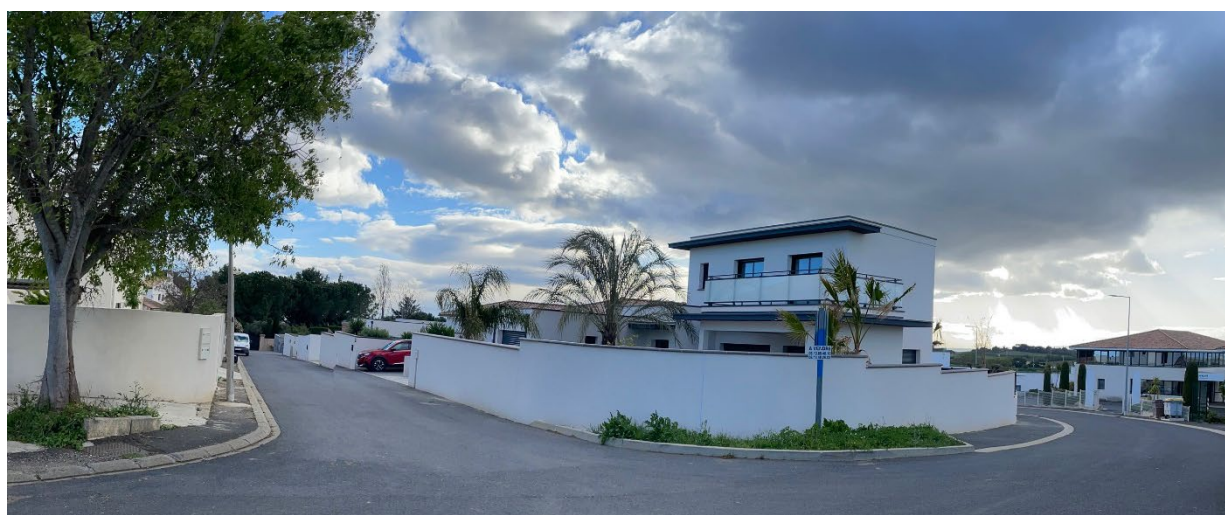
Constructions des 5 lots sur la rue Descartes
