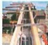
Mise en place d'un chaînage au niveau du compact d'un bâtiment
