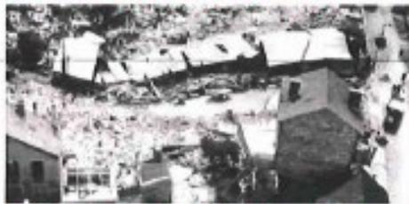
Le 1<sup>er</sup> juin 1961, un énorme grondement souterrain se fait entendre et, quelques instants plus tard, six hectares de carrière de craie s'effondrent sur une hauteur de deux à quatre mètres à la limite des communes de Clamart et d'Issy-les-Moulineaux. Six rues disparaissent et le terrain du stade d'Issy-les-Moulineaux fut transformé en paysage lunaire. On dénombre 21 morts, 45 blessés, plus de 273 sinistrés et 23 immeubles détruits.
