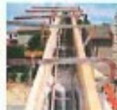
Mise en place d'un chaînage au niveau du contour d'un bâtiment
