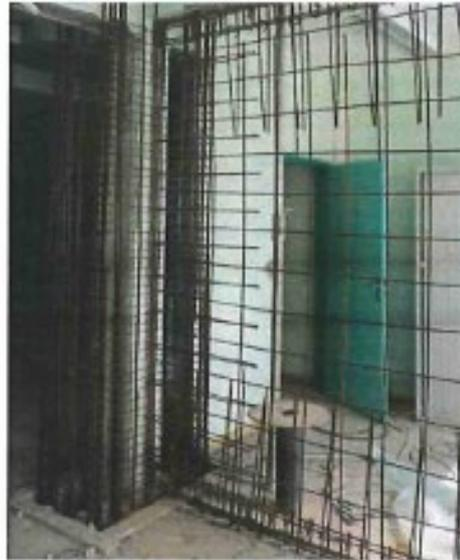
Exemple de renforcement parasismique
