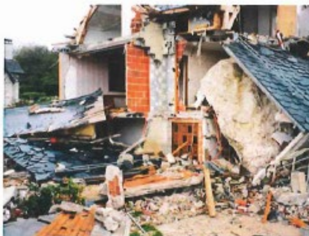
↳ Maison sinistrée par la chute d'un bloc
