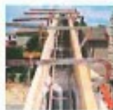
Mise en place d'un chaînage au niveau du comble d'un bâtiment
