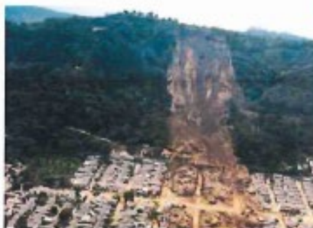
PC. Glissement de Las Collinas lors du séisme du 13 janvier 2001 au Salvador.
