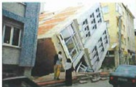
☞ Séisme d'Izmit (Turquie) : perte de portance par liquéfaction de sables du séisme du 17 août 1999
