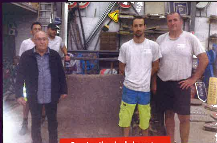
Construction du skate parc par les services techniques
