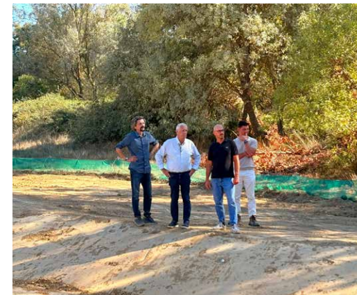
Le Maire Gérard Abella aux côtés des responsables des entreprises, lors de l'avancée des travaux
